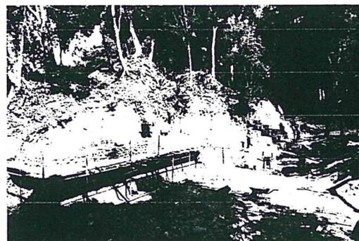
5. En el edificio B-18 en la Plaza Central de Naranjo se trabajó en la estabilización del talud en el antepenúltimo cuerpo de la fachada oeste extremo norte, en donde se estabilizó 10 m<sup>2</sup> entre relleno constructivo y muros que aún conservan sus sillares originales.
